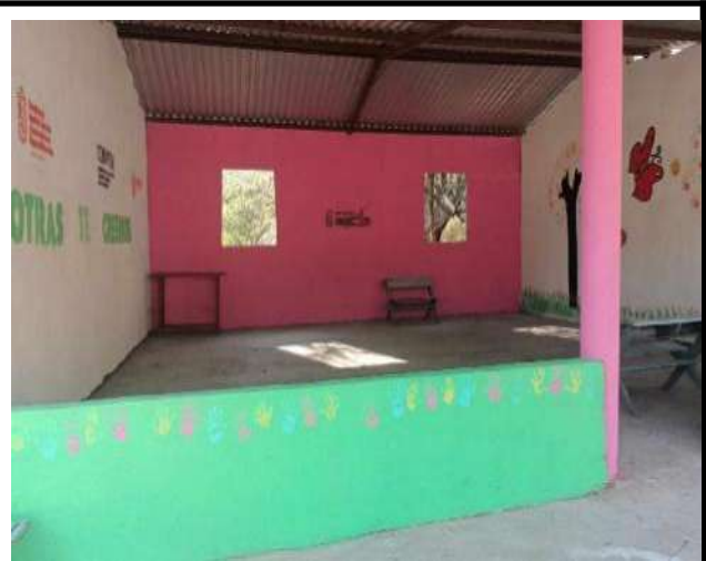
En esta imagen se observa cómo quedó el espacio recuperado, en la casa comunal de la comunidad de El Gusano, Municipio de Huetamo, Michoacán 27/11/2024
