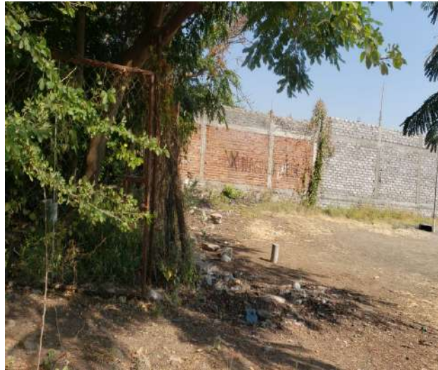
Así se encontraba esta pared de la calle principal de la colonia Lázaro Cárdenas, justo frente a un espacio recreativo que utilizan para hacer deporte. (Diciembre 2024)
