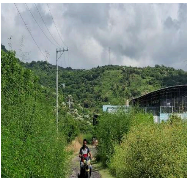
Esta calle requiere alumbrado público de la calle. No hay postes de luz y constantemente acuden al lugar varias personas a visitar a sus familiares en distintos horarios.
